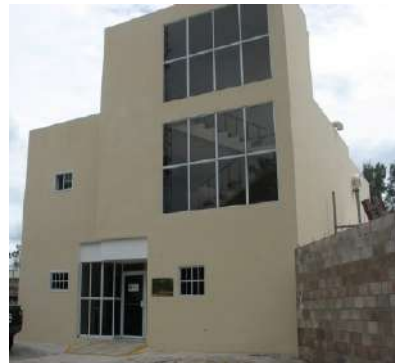
Edificio Laboratorio Calidad de Agua
